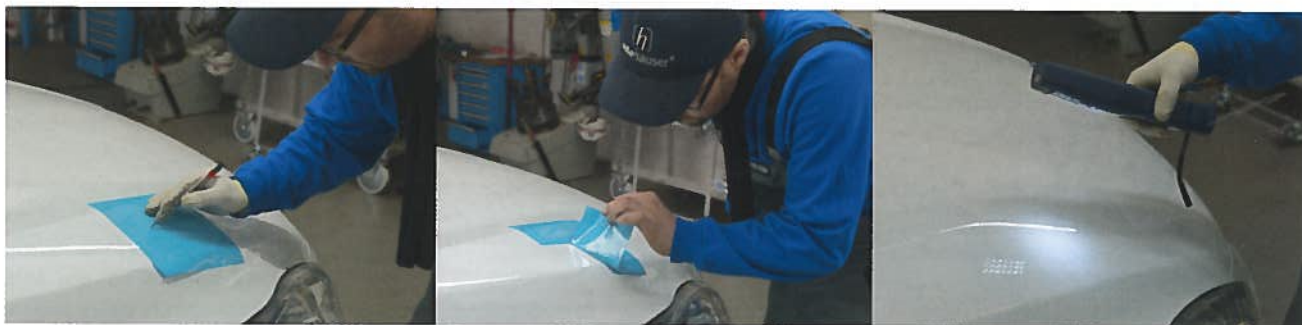
Geschnitten wird mit Skalpell, die mit ihrem Eigengewicht 80 % der Folie durchtrennen. Der Rest wird gerissen. Das Prüflicht zeigt: Der Lack ist unbeschädigt.
